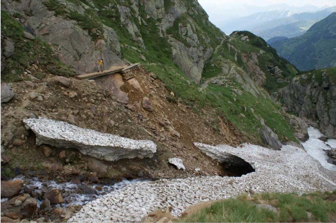
**Abb. F- 6:** Beispiel einer aufwändigen Wegsanierung durch Einbau einer Hangbrücke nach flächenhaftem Abgleiten des ursprünglichen Hanges auf Grund dessen Unterschneidung durch das im Vordergrund sichtbare Gerinne (Ridnauntal, Stubaier Alpen) (Foto: G. K. Lieb, 15.7.2010).
